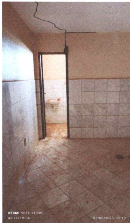
Foto 09 - Vista do piso sera demolido
