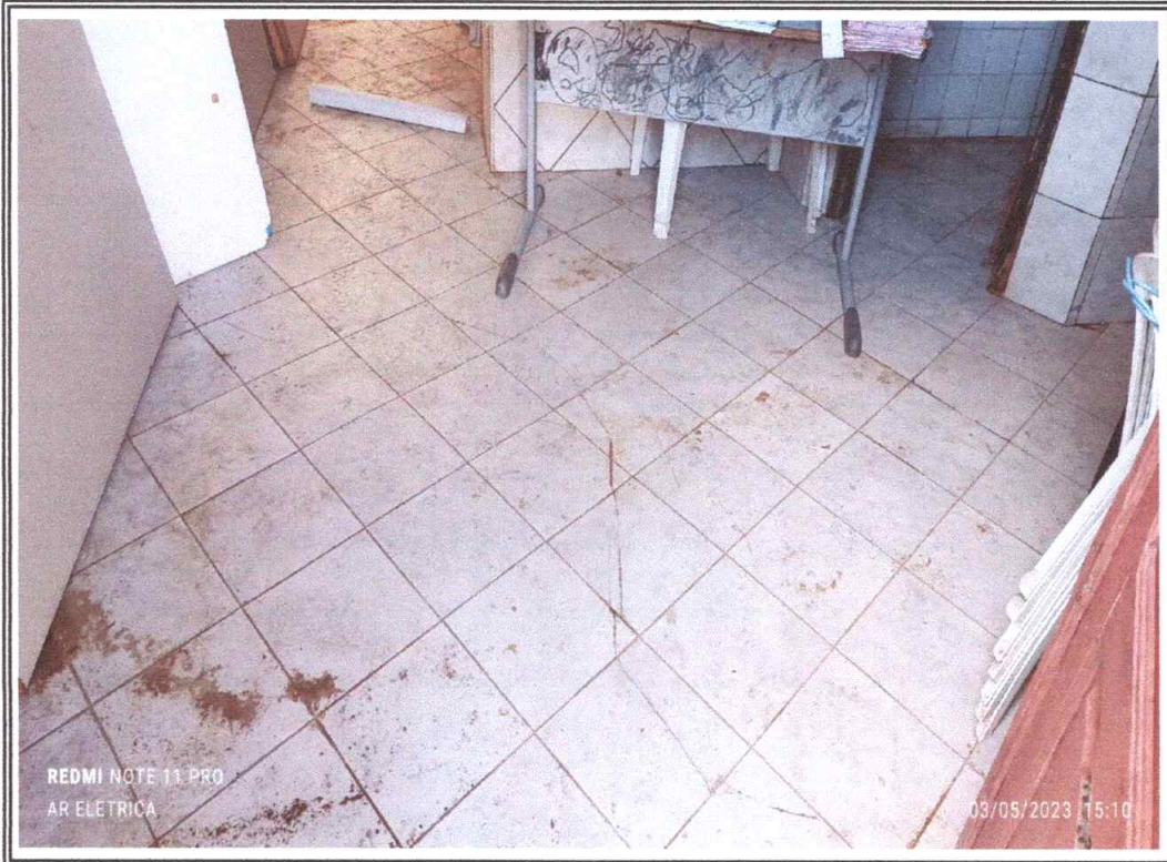
Foto 15 - Vista do local que haverá remoção de cerâmica e instalação de pisos ceramicos
