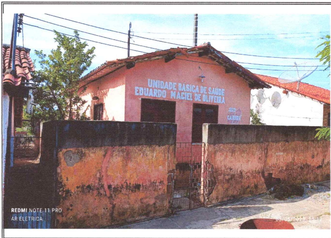
Foto 01 - Vista da fachada
