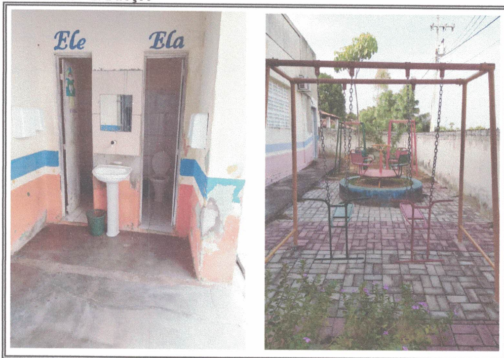
Foto 03 - Reboco danificado
