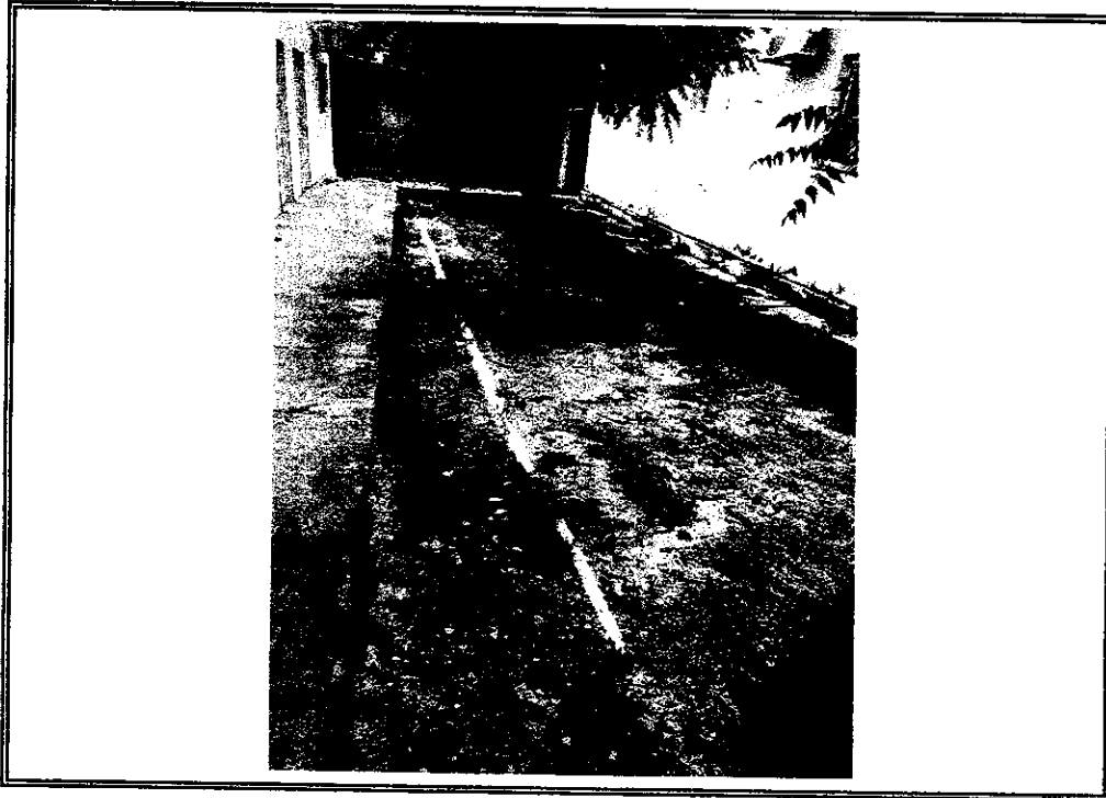
Foto 21-LOCAL ONDE SERA COLOCADO BRITA
