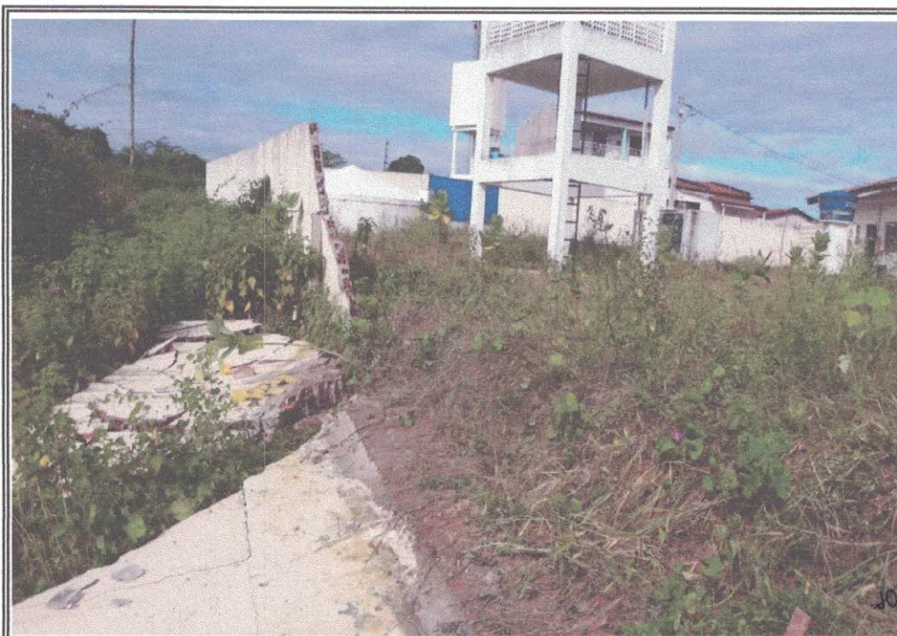
Foto 02: Parede danificado.
