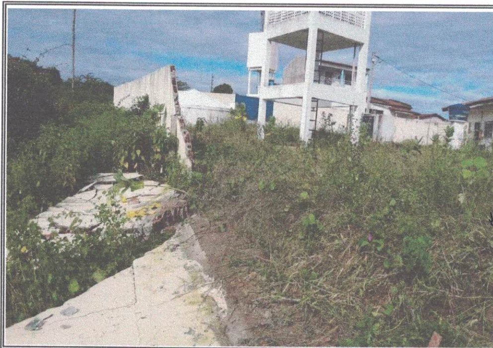
Foto 02: Parede danificado.
