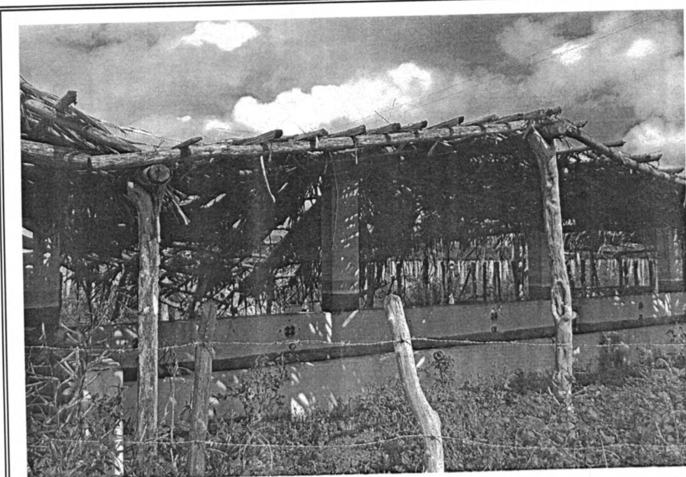
Foto 02: Substituição de telha de palha por telha cerâmica .
