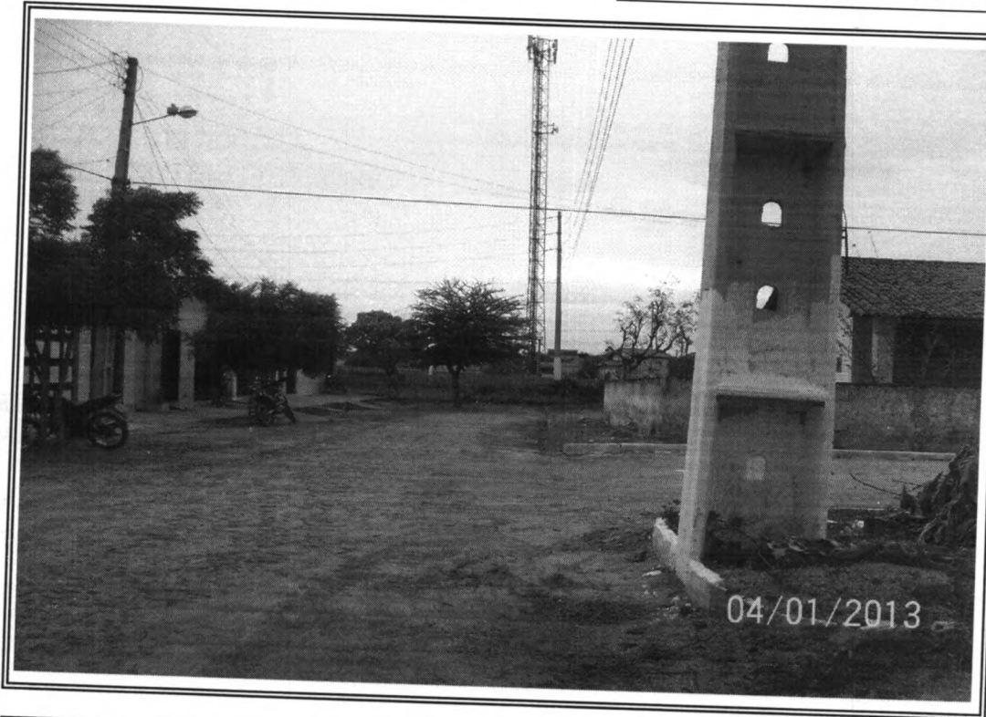
Foto 01 - Continuação da Rua José Teles sem pavimentação.
