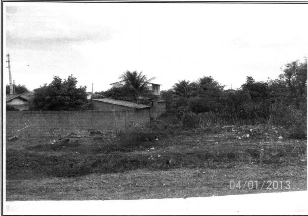
Foto 05 - Parte do percurso da drenagem.
