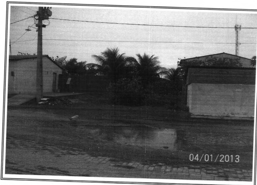
Foto 02: Início do Trecho a ser construído com drenagem com manilhas de 40mm.
