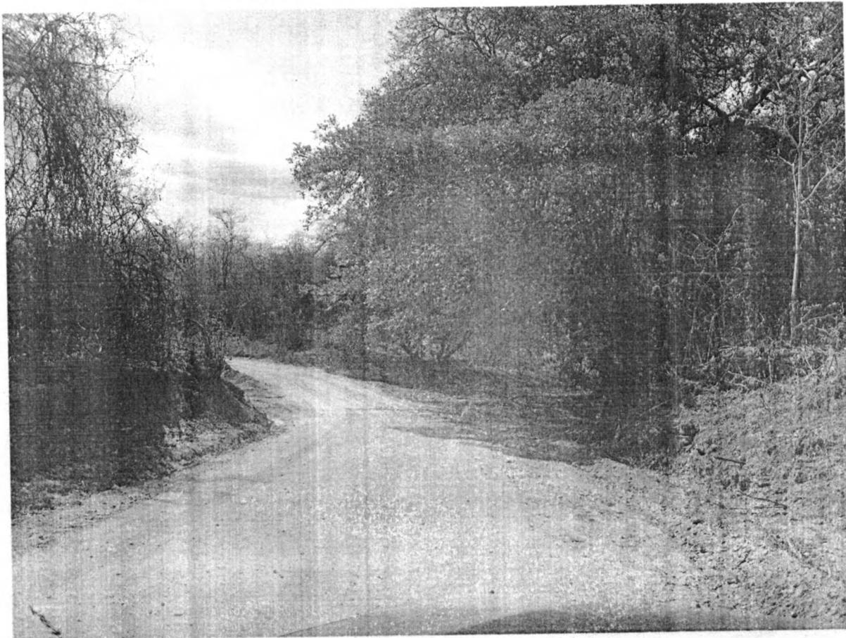
FOTO 02: VISTA ONDE SERÁ CONSTRUIDA A PASSAGEM MOLHADA
