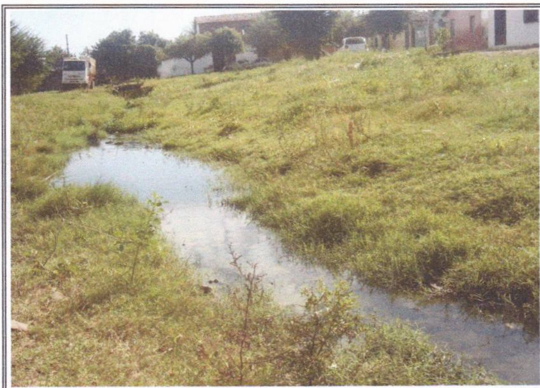
Foto 06 - Trecho com odor desagradável, incomodando e trazendo doenças para os moradores da área.
