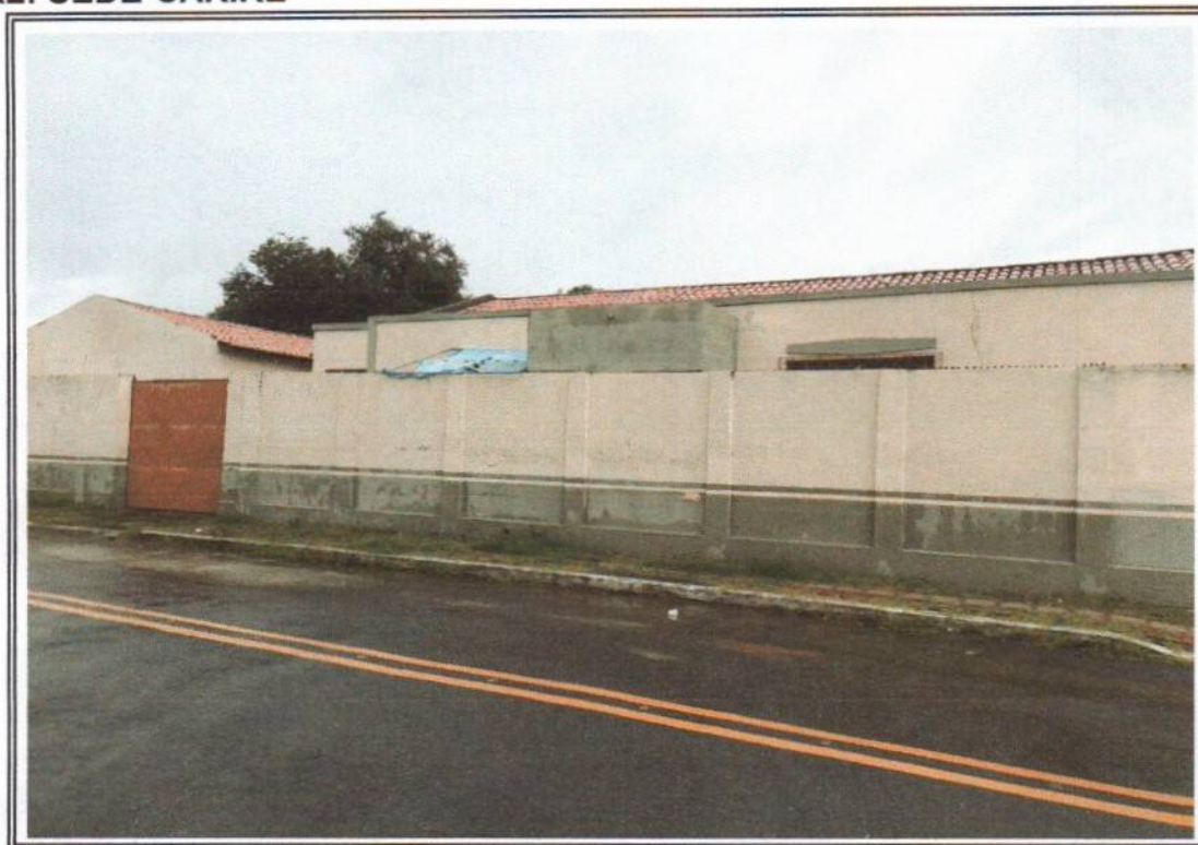
Foto 03 - Vista onde sera feito telhado
