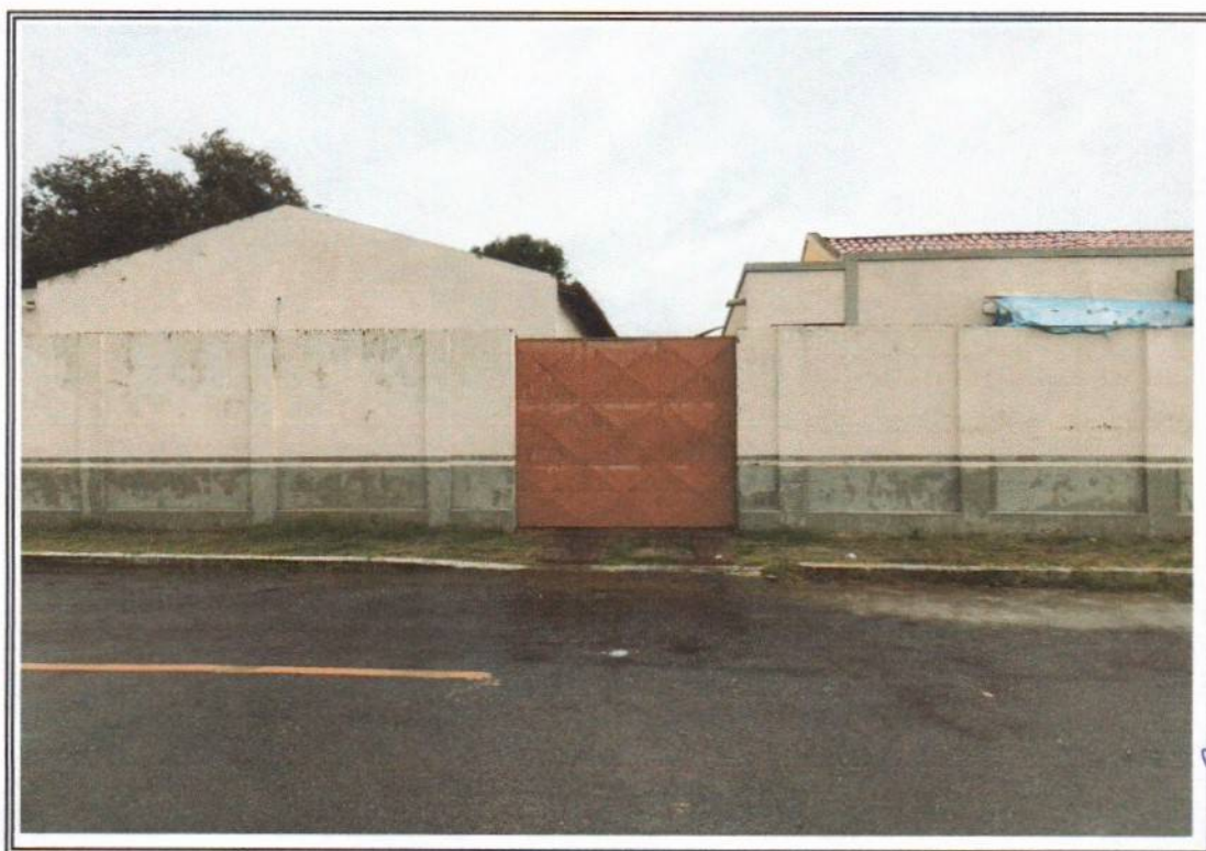
Foto 04-Vista telhado executado telhado
