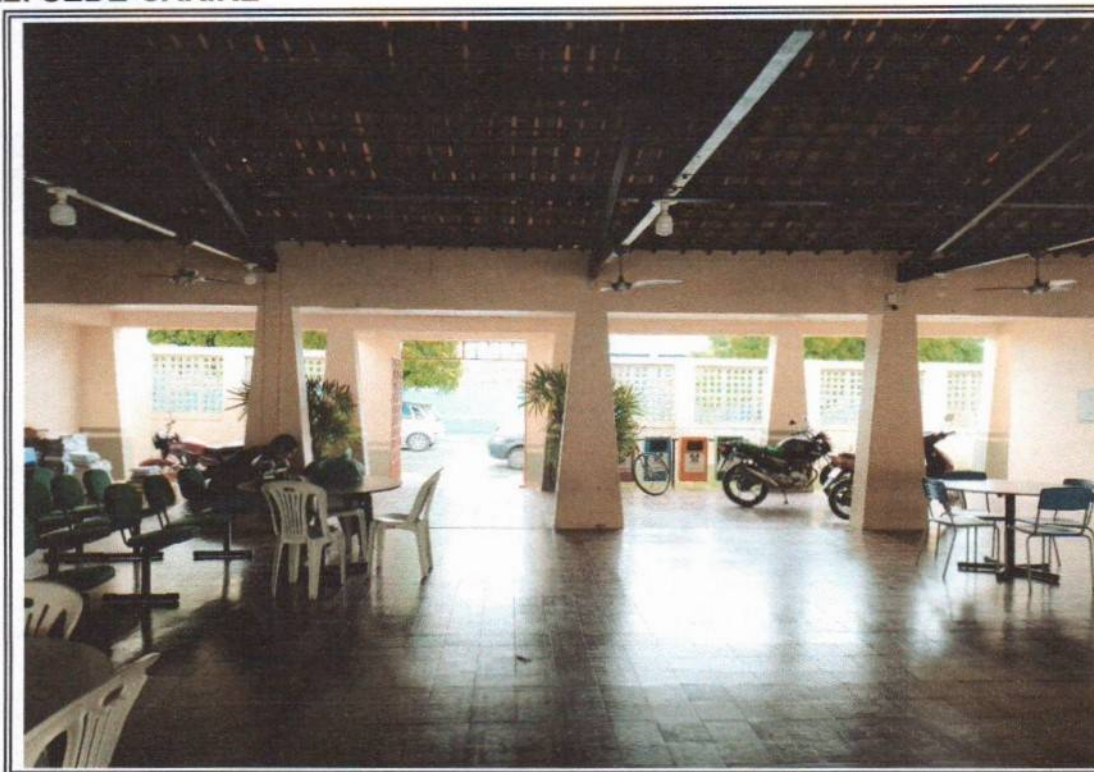
Foto 05 - Vista do local que sera retelhado
