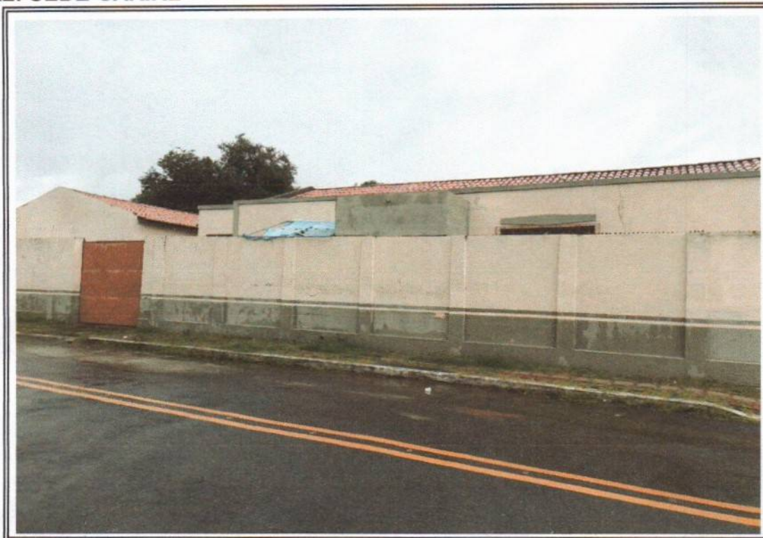
Foto 03 - Vista onde sera feito telhado
