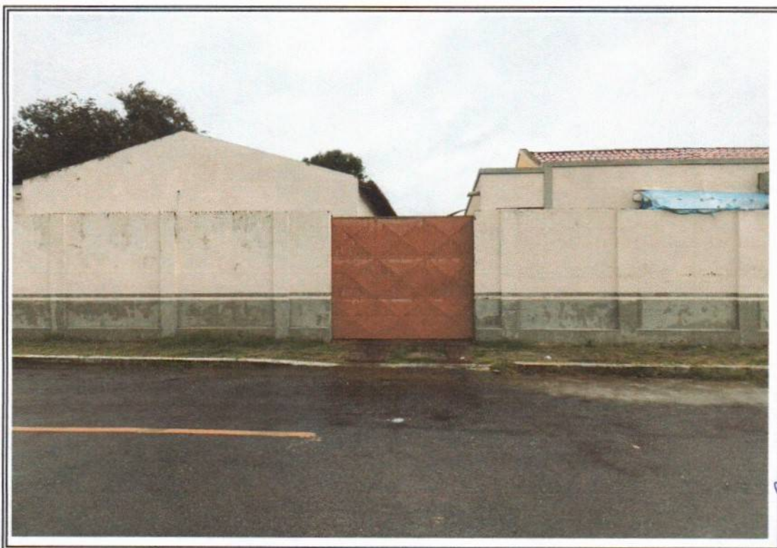
Foto 04-Vista telhado executado telhado
