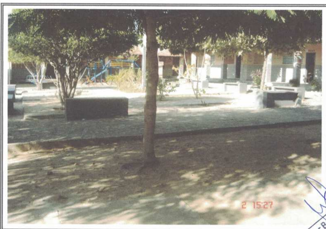
Foto 08- Espaço onde será construído o refeitório.
