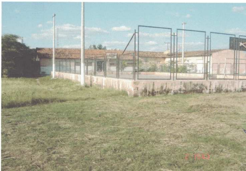
Foto 10- Quadra esportiva pronta para ser coberta com estrutura metálica.
