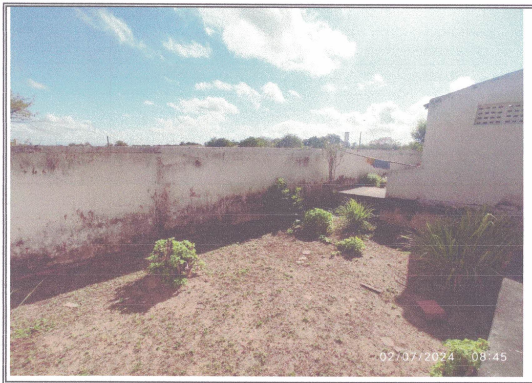
Foto 11 - Vista do muro
