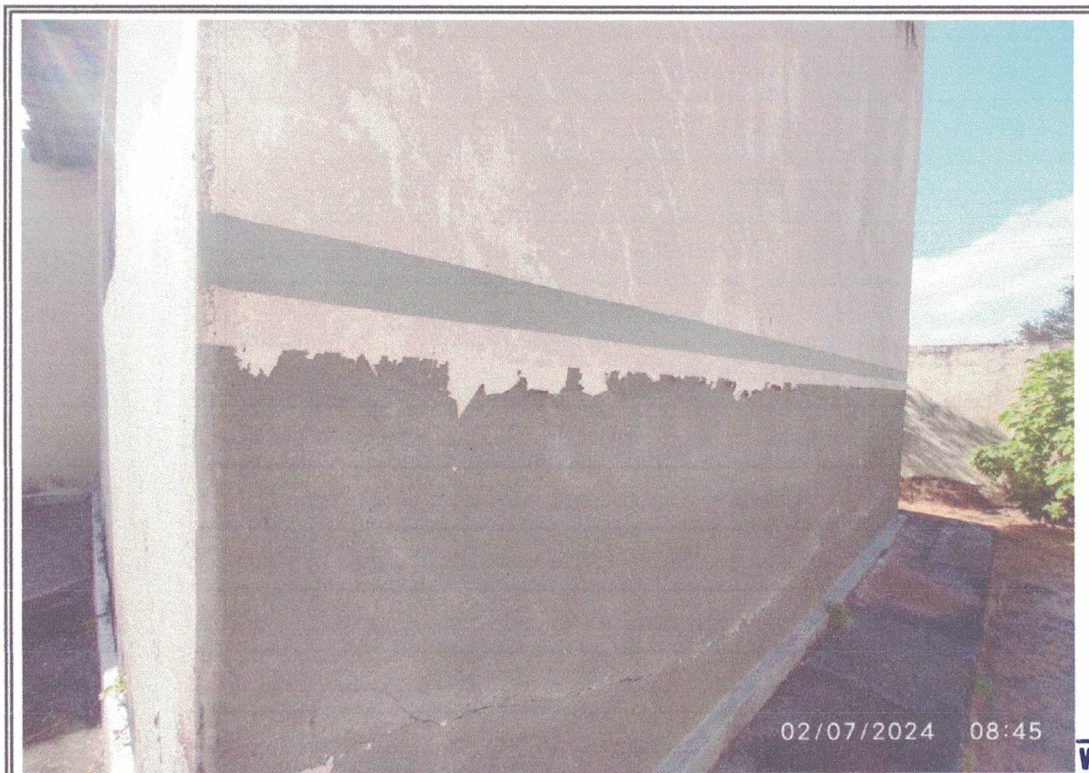
Foto 08- Paredes infiltração
