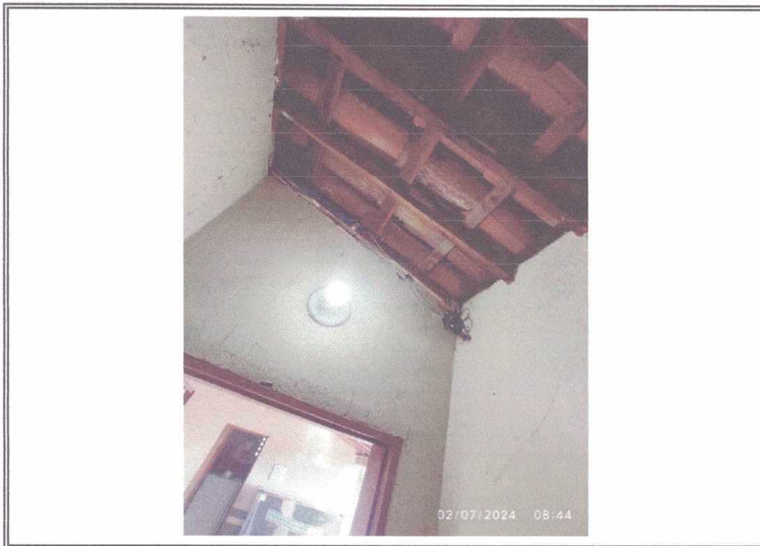
Foto 09 - Vista do telhado da escola
