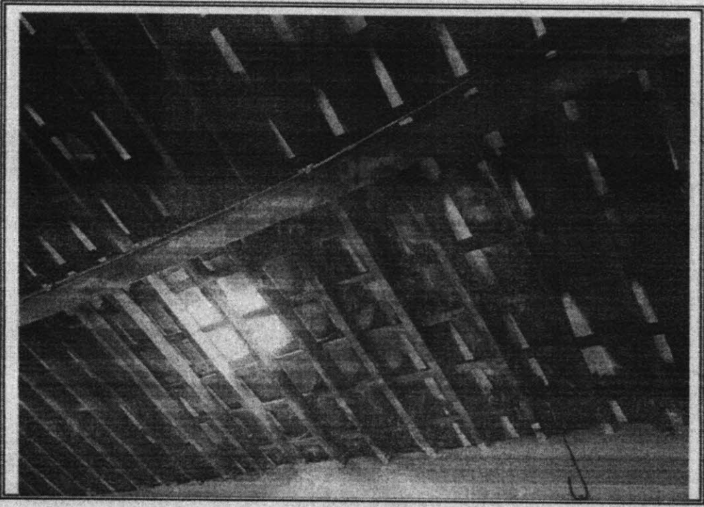
Foto 12- Vista do telhado e substituido a calha
