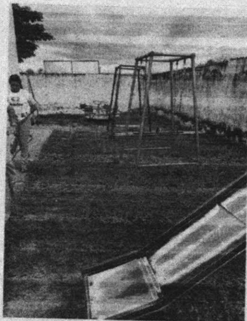
Foto 03 - Vista onde sera feito telhado e ampliacao refeitorio
