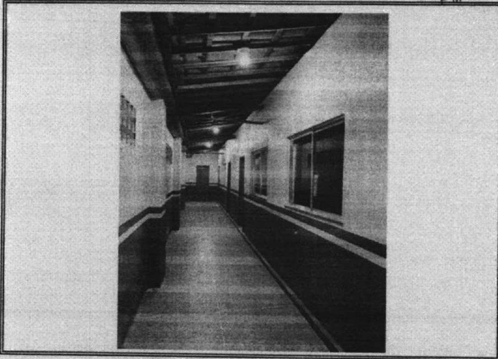
Foto 01 - Vista onde sera colocado portao
