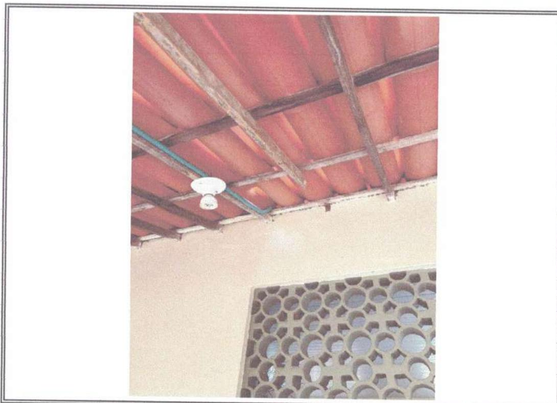
**Foto 06- Vista do local que sera substituido telhado**
