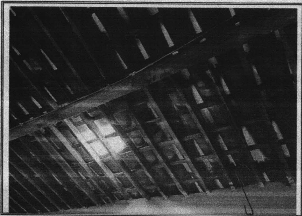
Foto 12- Vista do telhado e substituido a calha
