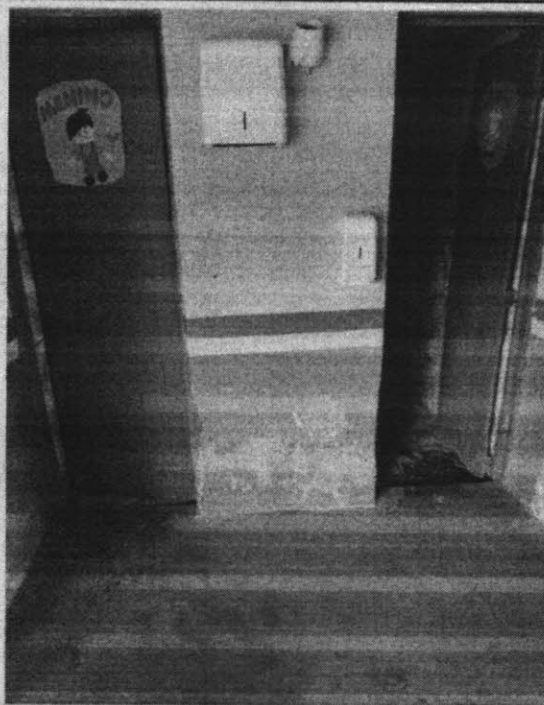
Foto 10-Vista das paredes serem demolidas
