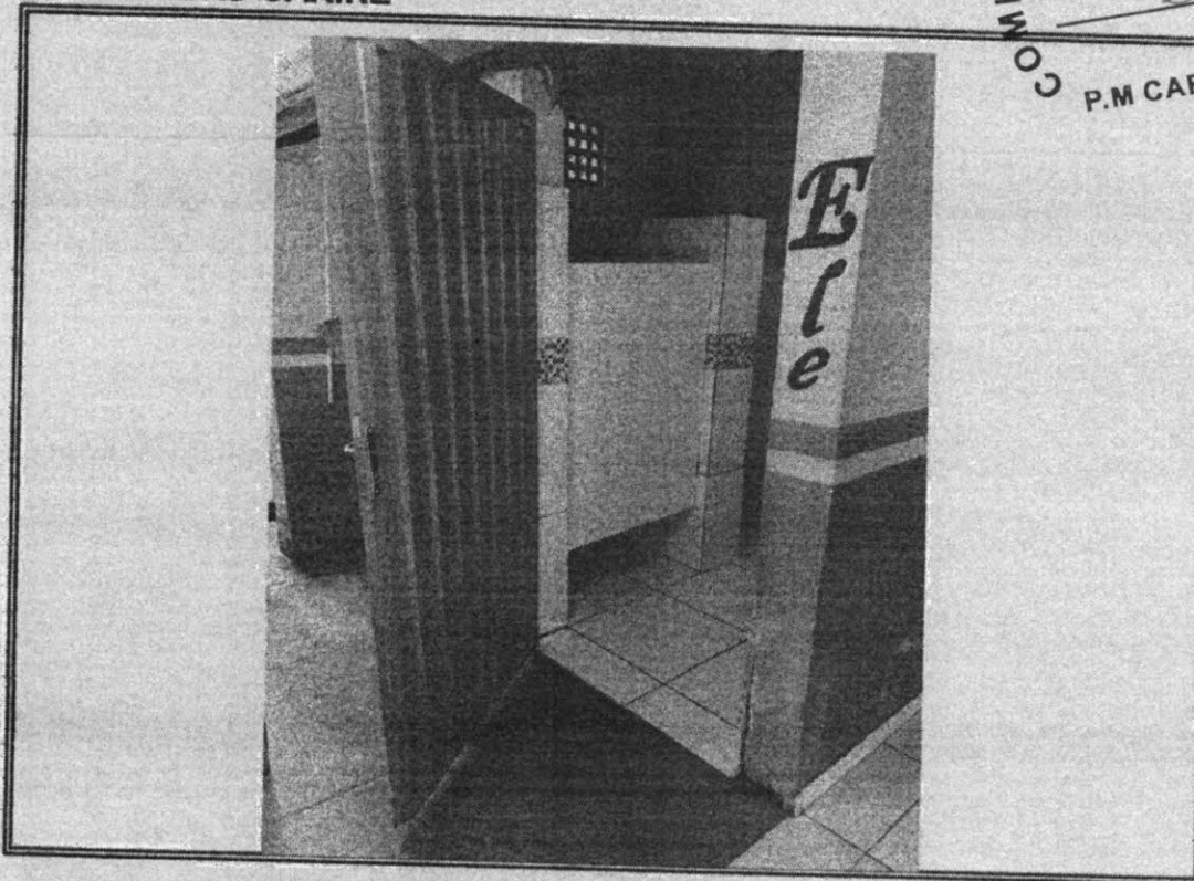
Foto 05 - Vista do local que sera demolido wc
