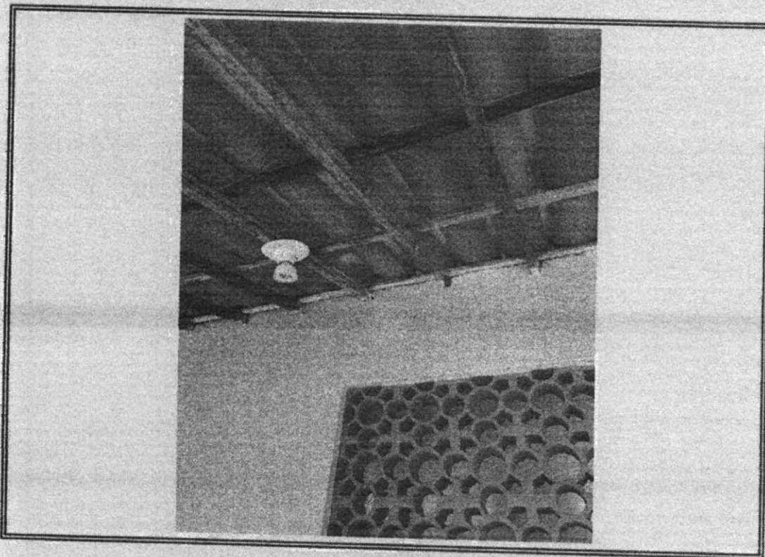
Foto 06- Vista do local que sera substituido telhado
