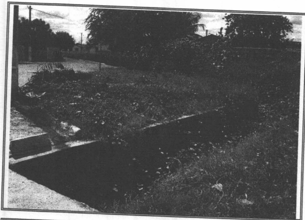
Foto 02: Trecho próximo a residências.
