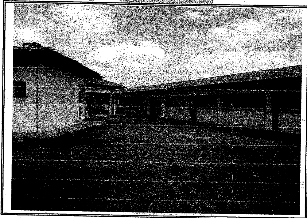
Foto 07 - Local onde será executado refeitório
