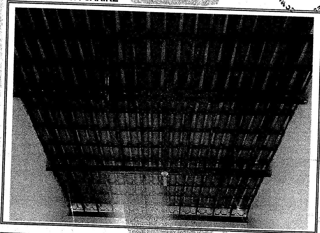
Foto 05 - Vista do local de retelhamento
