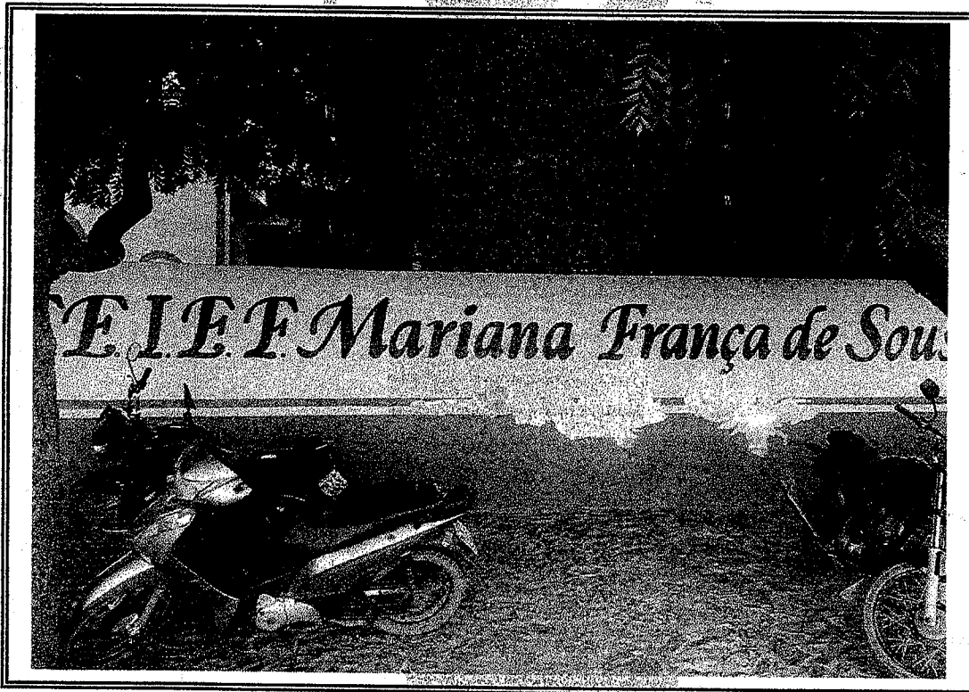
Foto 02- Vista do local pintura danificada
