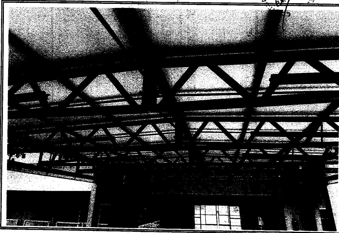
Foto 19 - Vista de local que sera colocado as calhas
